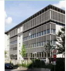
Aufstockung und Modernisierung des Bürogebäudes am Orleansplatz 9
